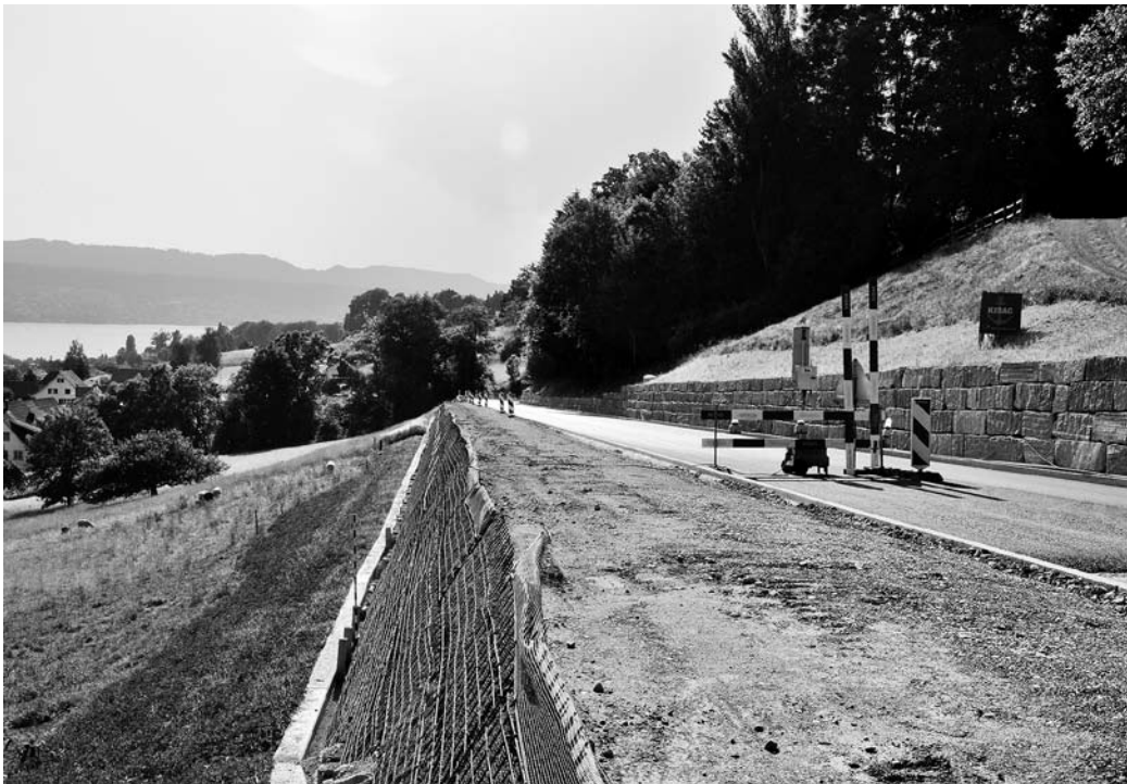
Fast doppelt so breit: Die erste Etappe der Bergstrasse wird im Herbst fertig.
