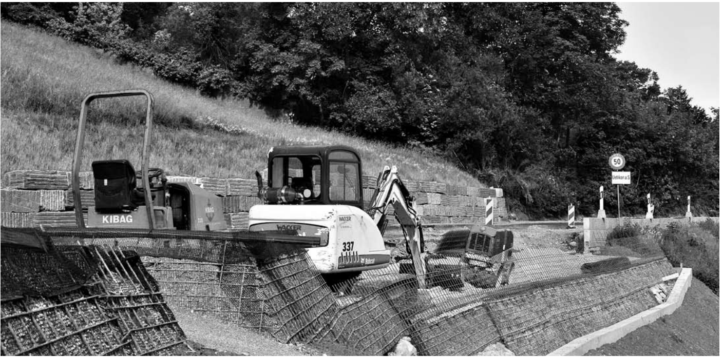
Der Neubau der Bergstrasse ist aufwändig – nicht zuletzt aufgrund des 60 Grad steilen, bepflanzbaren Naturbords.
